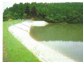
改修後の 農業用ため池
